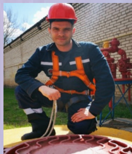
МОНТЕР ПО ЗАЩИТЕ ПОДЗЕМНЫХ ТРУБОПРОВОДОВ ОТ КОРРОЗИИ ЕВГЕНИЙ БОРИСОВЕЦ (ПУ «СЛУЦКГАЗ»)
